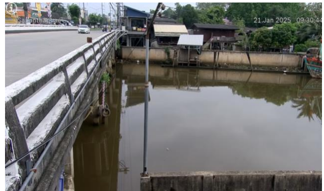
TC191911 : สะพานวัดท่าแพ ต.ปากพูน อ.เมือง จ.นครศรีธรรมราช
